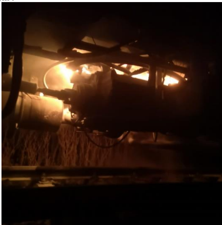
Imaginea nr. 1 – flăcări deasupra motorului Tedom (foto făcută de personalul de exploatare)
