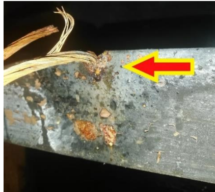
Imaginea nr.8 – detaliu cu cablul electric sudat de platbanda din tablă
