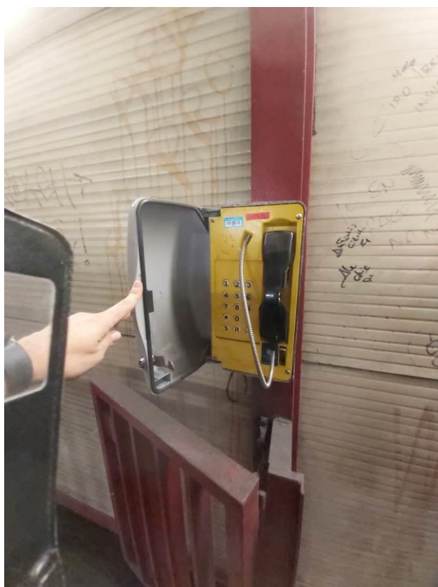
Foto 11 e 12: Telefoni fissi di tipo “automatico” posti lungo la banchina di stazione a Pozzano: il primo a centro banchina, il secondo a fine banchina, direzione Castellammare (fonte Ufficio)
