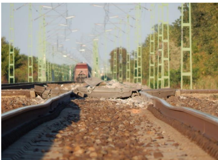
5. ábra: a kisiklás helyét megelőző vágánygeometriai hiba
