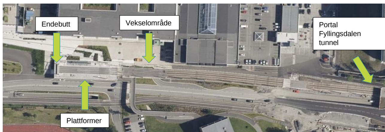
Figur 18: Oversikt over Fyllingsdalen terminal. Kilde: Kystinfo, Kystverket. Påtegning: SHK
