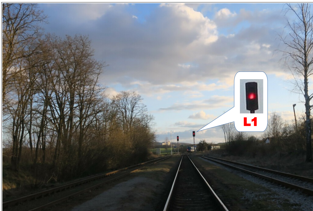
Obr. č. 3: Odjezdové návěstidlo L1 žst. Vlastec
