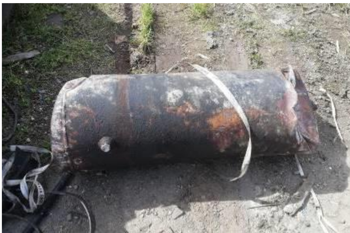
Foto nr.8 – Rezervorul de aer
