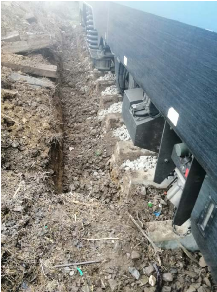
Foto nr. 4: Starea traverselor și a prisme de piatră spartă din vecinătatea punctului „0”
