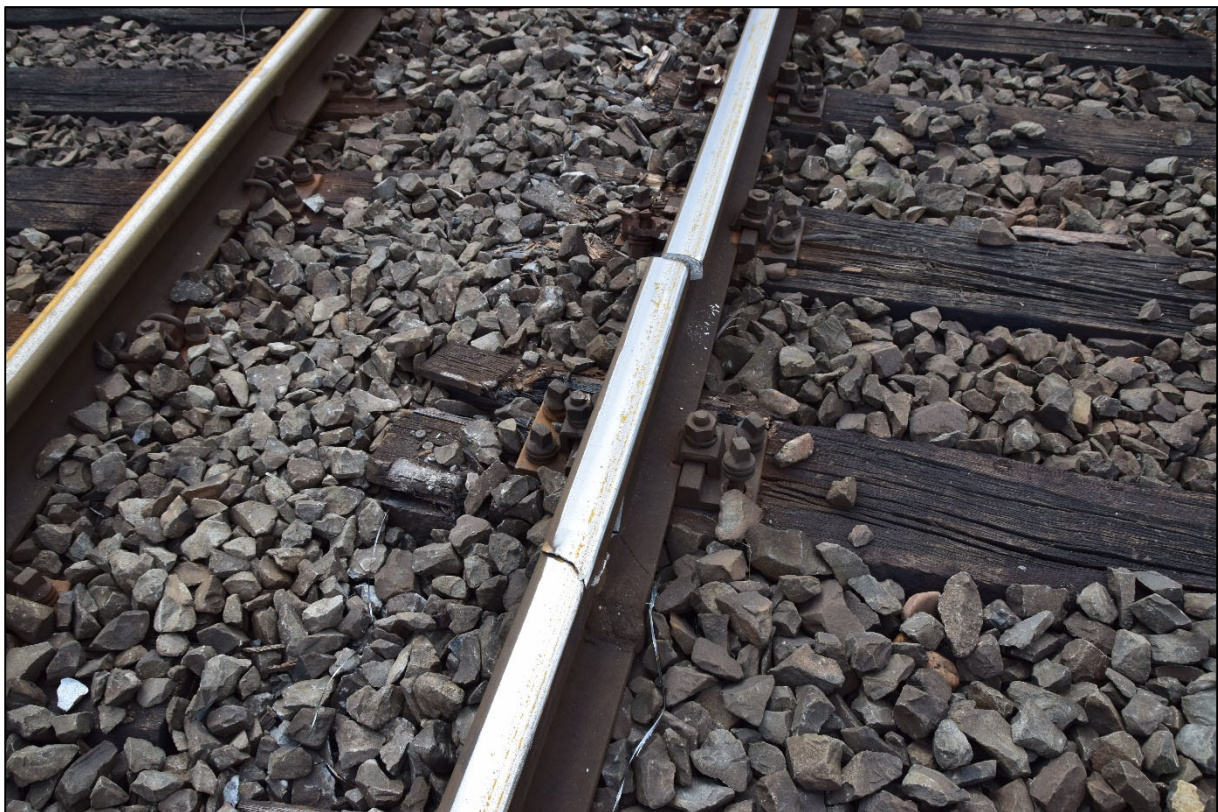
Abbildung 3: Schienenbruch hinter der Weiche 12 3
