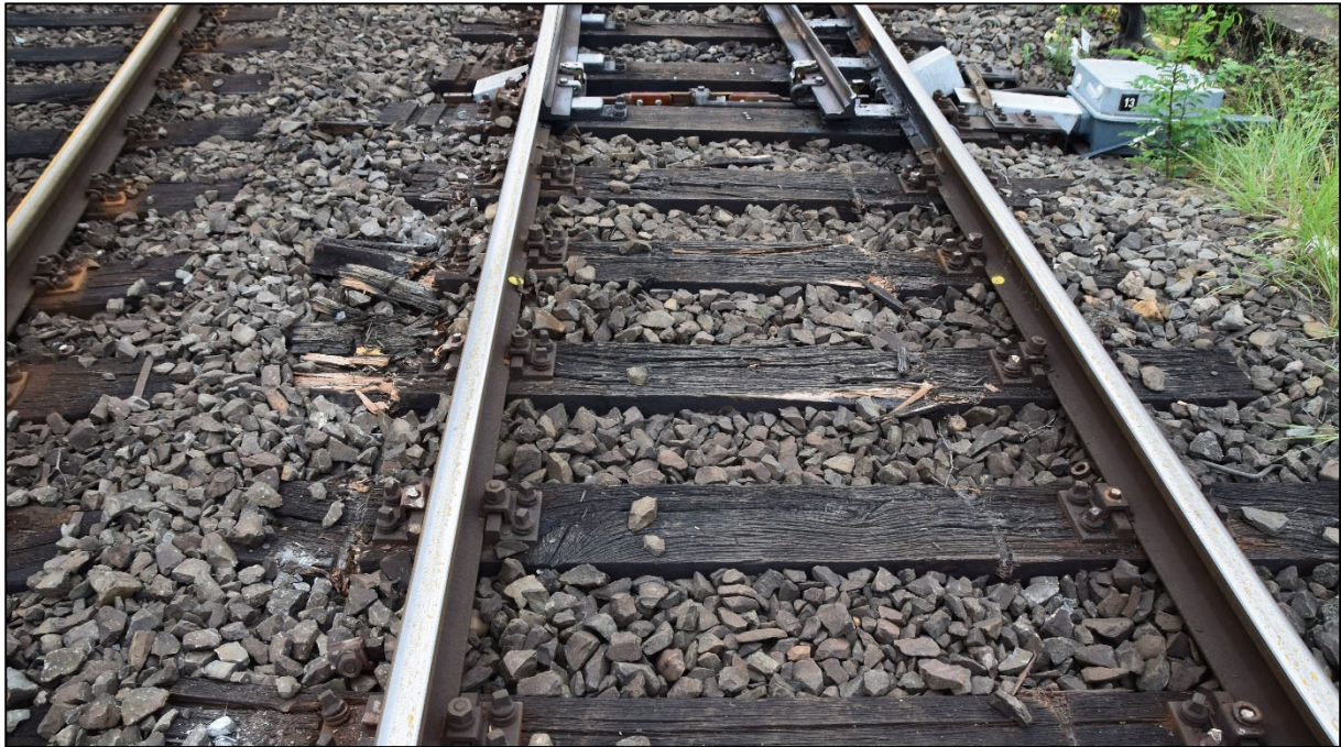
Abbildung 4: Beschädigungen des Oberbaus 4
