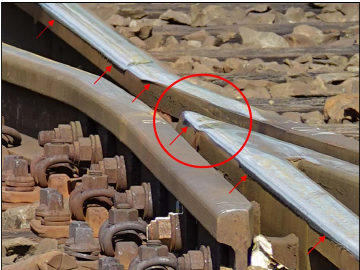
Abbildung 18: Abgenutzte Flügelschiene und Herzstückspitze
