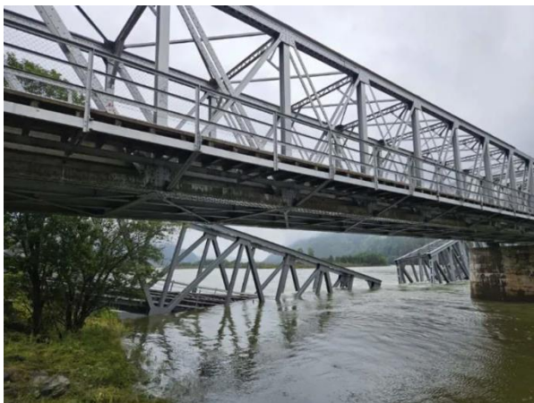
Figur 24: Flommen etter «Hans» ødela fundamentet til Randklev bru, Dovrebanen. Foto: Bane NOR SF
