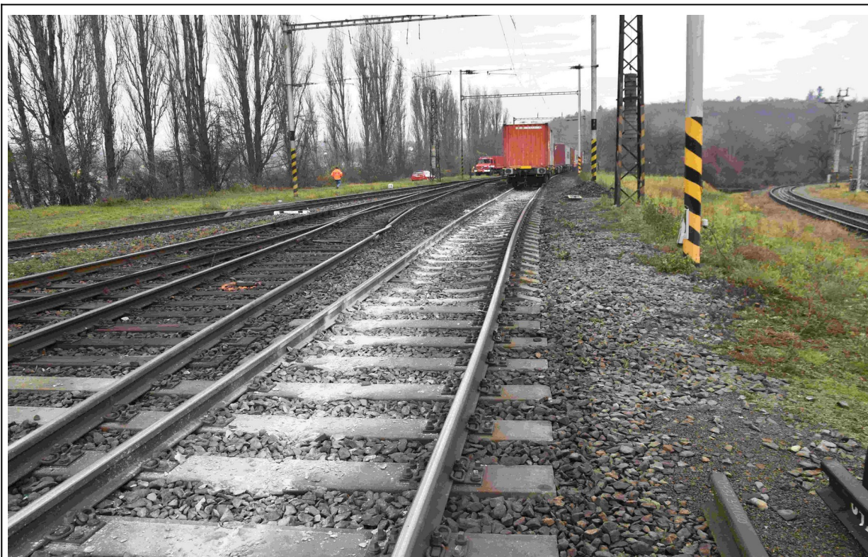
Obr. č. 3: Poškození traťového svršku za výhybkou č. 48b po odvezení nevykolejených vozů Zdroj: DI
