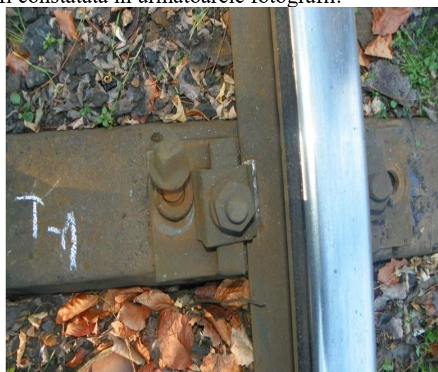
Foto.nr.9 - Traversa T -1
