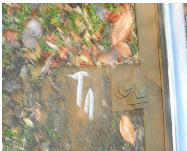
Foto.nr.12 - Traversa T 1
