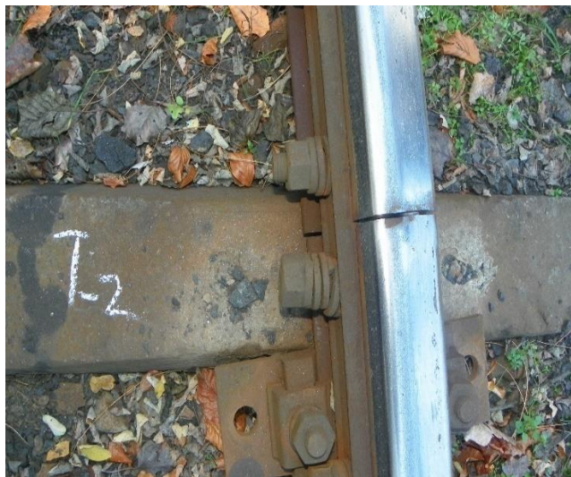
Foto.nr.10 - Traversa T 2
