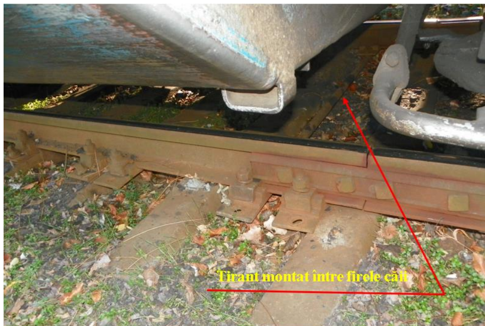
Foto.nr.7 - Tirant montat între firele căii
