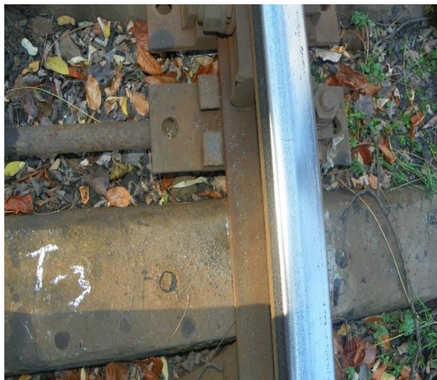
Foto.nr.11 - Traversa T 3
