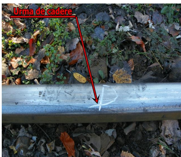
Foto nr.5: Punctul „D” - urmă de cădere în exteriorul căii (roata din partea dreaptă a osiei nr.5)
