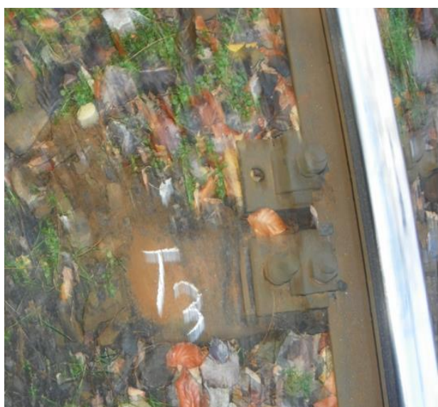
Foto.nr.14 - Traversa T 3
