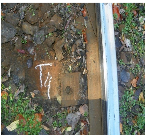
Foto.nr.15 - Traversa T 4
