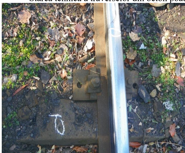
Foto.nr.8 - Traversa T 0
