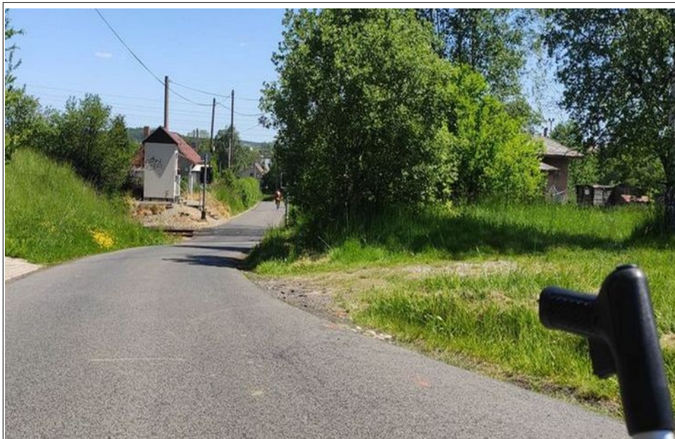
Obr. č. 3: Viditelnost výstražníku ve směru jízdy od Dymníku nebyla zajištěna na požadovaných 40m Zdroj: DI
