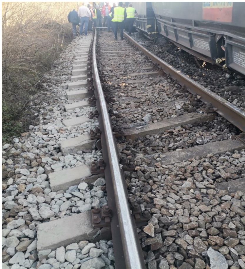
Foto nr.17 – deriparea liniei II directă, traverse din beton răsucite și strivite pe zona de rezemare
