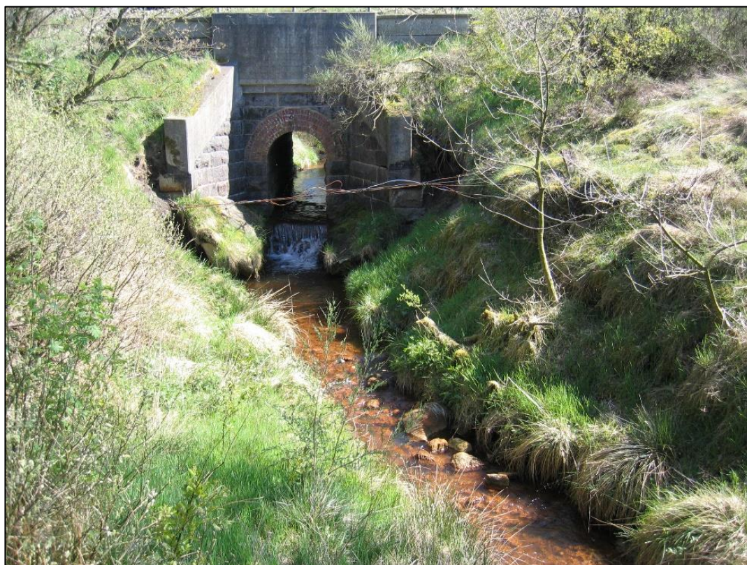
Foto 5. D. 12-05-2005. Udløbssiden af vandløbsbroen. Manglende materiale i bunden af vandløbet ved udløbet, og i brinken ved begge fløjmur. Kilde: Privat foto.
