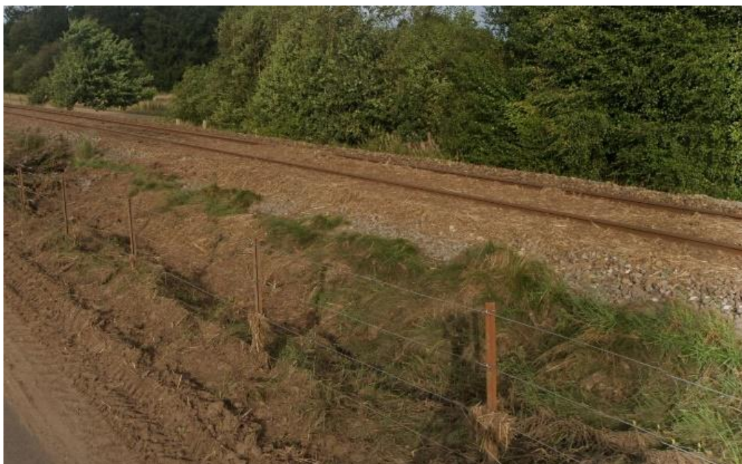
Foto 13. Sporet i km 87,7 set fra Ollingvej. September 2022. Mudder afsat langs hegnet. Plantedele tilbageholdt af skærverne. Kilde: Google Streetview.
