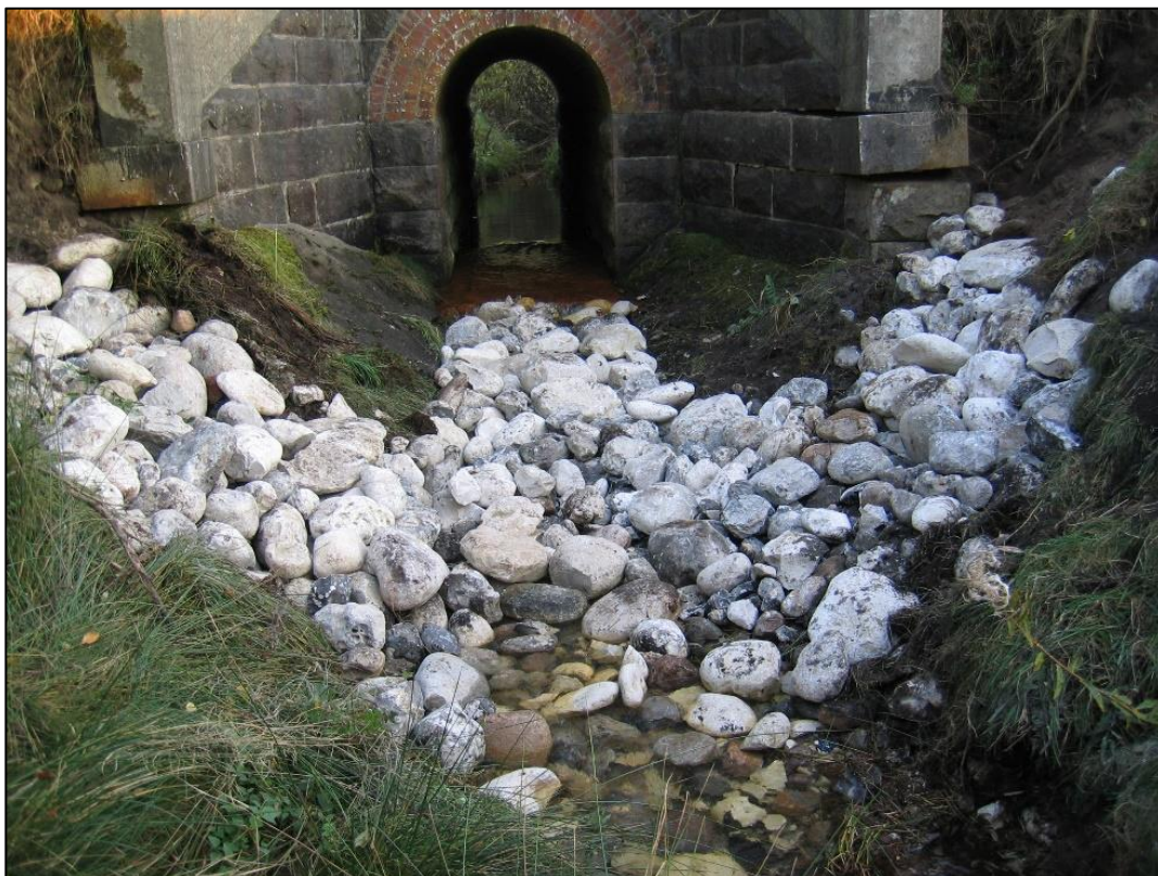
Foto 6. D. 12-10-2005. Udløbssiden af vandløbsbroen. Reparation af vandløbsbund og brinker med marksten. Sætningsskade på vestlige fløjmur. Kilde: Privat foto.
