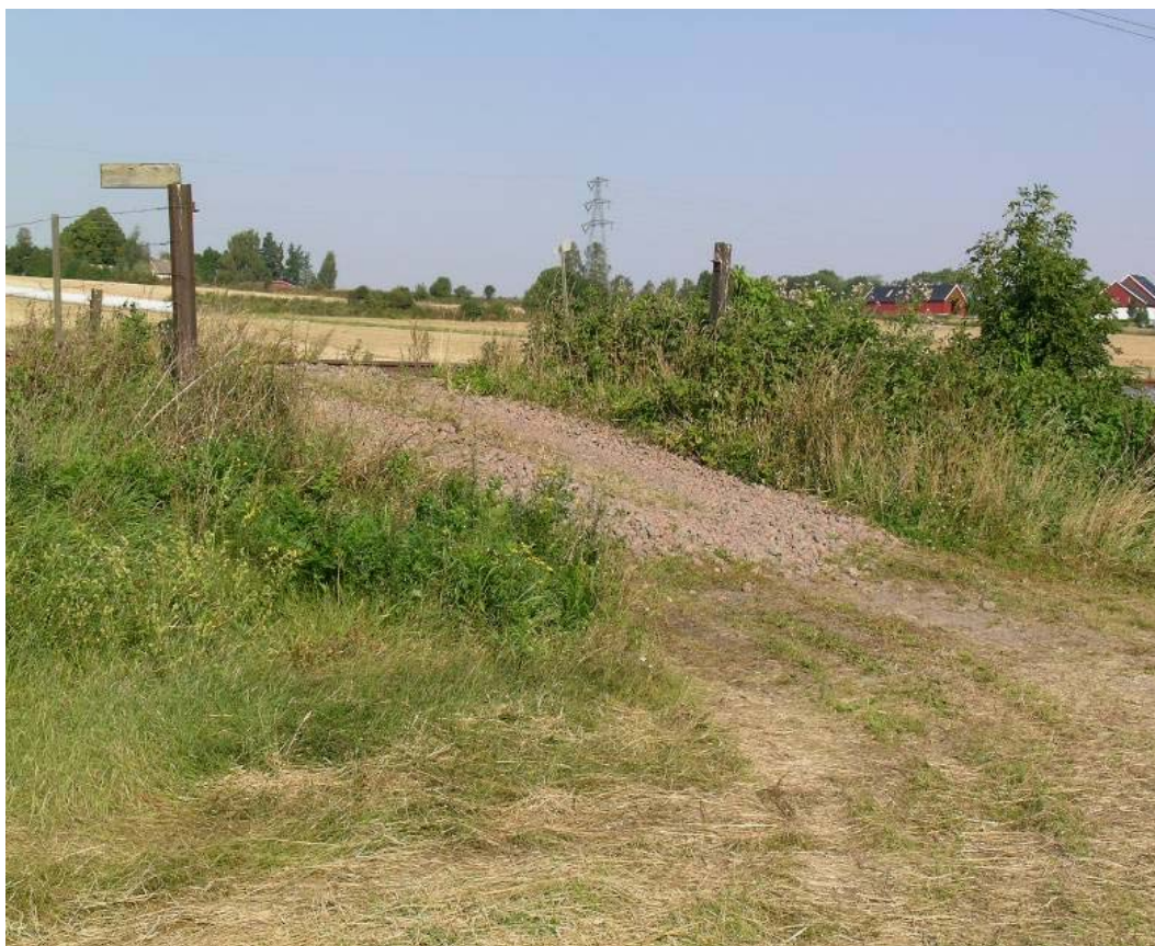
Figur 1: Bilde av planovergangen sett i lastebilens kjøreretning.
