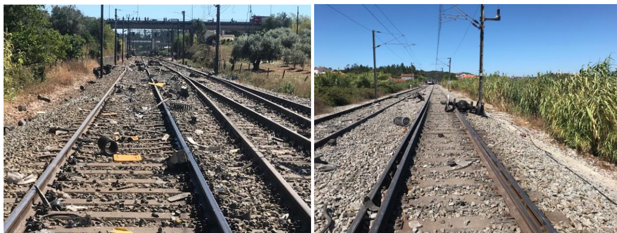
Figura 24: Componentes do BAN do CPA 4005 espalhados na via entre o local da colisão e o AMV 2II (à esq.) e rodado 2 do primeiro bogie do BAN imobilizado na ponta do AMV 2I, sobre a via D (à dir.)
