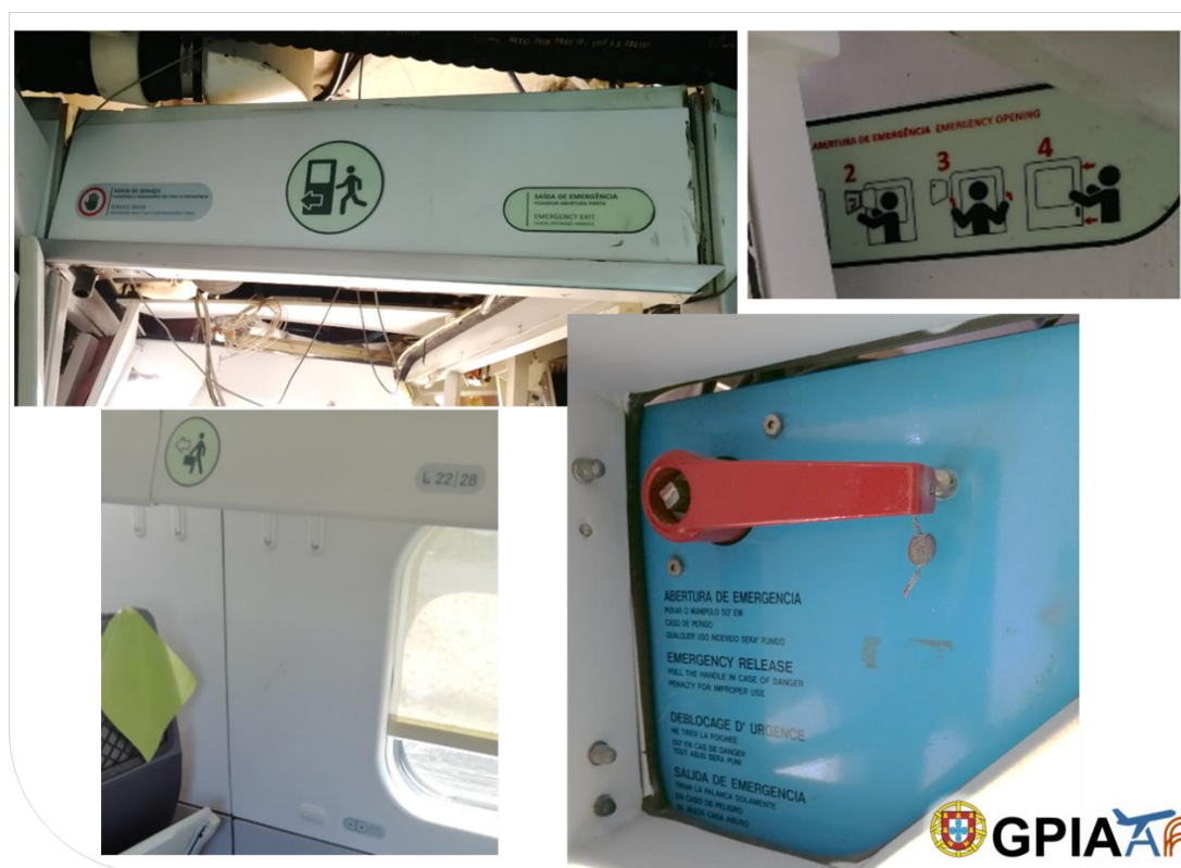
Figura 87: Sinalética respeitante à evacuação e abertura de emergência das portas
