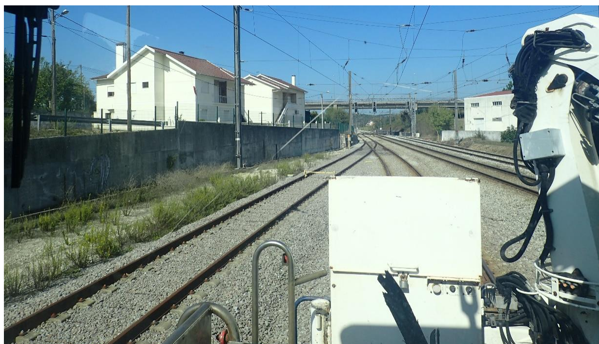
Figura 42: Aspeto da visualização do pórtico de sinais de Soure pelo maquinista, desde o local onde o VCC 105 estava parado
