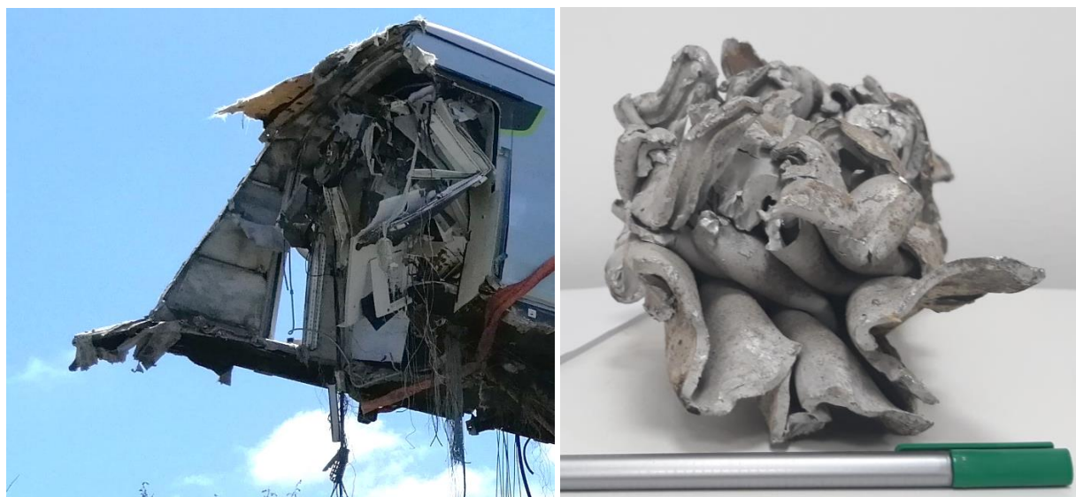
Figura 72: Lado esquerdo: Estado em que ficou a extremidade do BAN, mostrando como toda a zona da cabina se separou da estrutura tubular da caixa. Lado direito: Exemplo do funcionamento das estruturas de deformação controlada para absorção de energia na zona que se separou da caixa, com deformação em harmónio.
