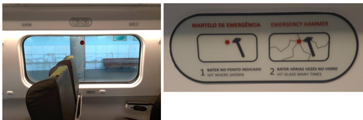
Figura 85: Vista interior de uma janela de emergência do BAN e pormenor da sinalética anexa
