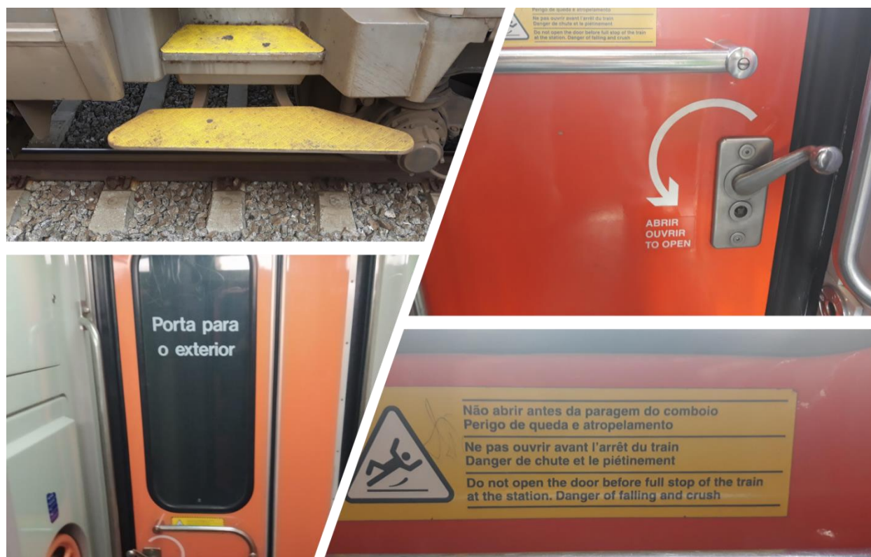
Figura 14: Revestimento e pintura antiderrapante nos degraus e informação no interior das portas
