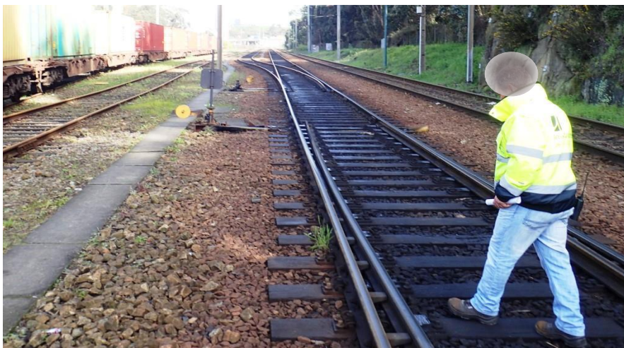
Figura 22: Atravessamento para as linhas da estação/sector da triagem
