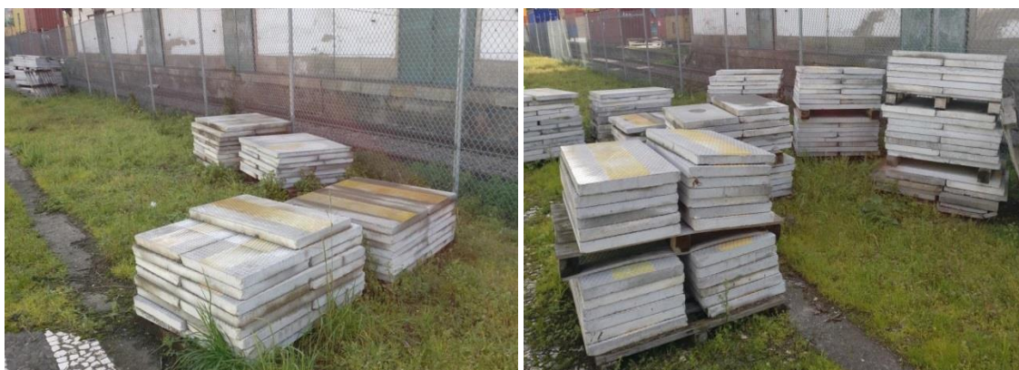
Figura 25: Lajetas depositadas na gare da estação de Leixões, não aplicadas
