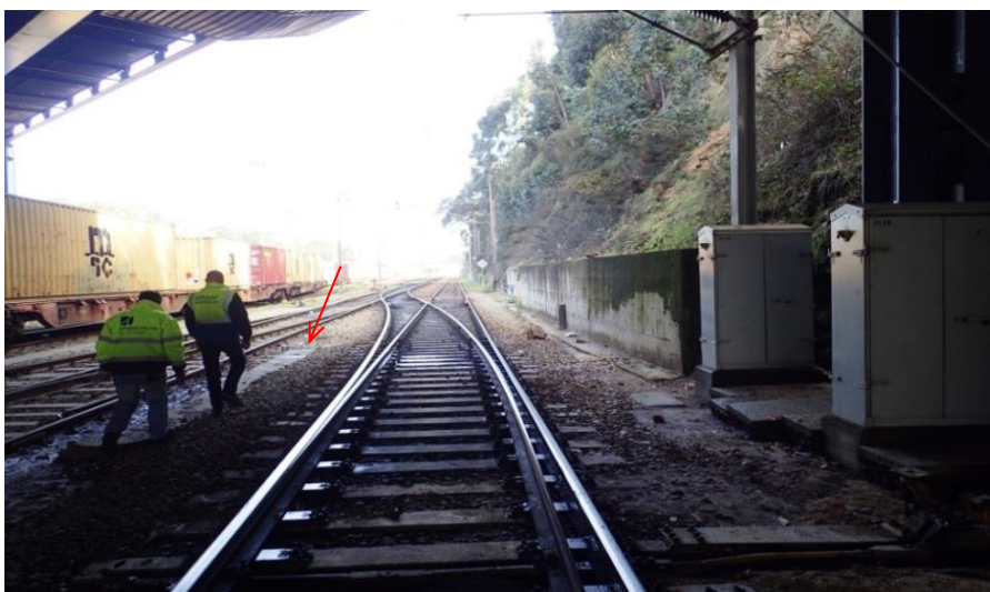
Figura 32: Passadiço descontínuo paralelo às linhas da estação/sector da triagem
