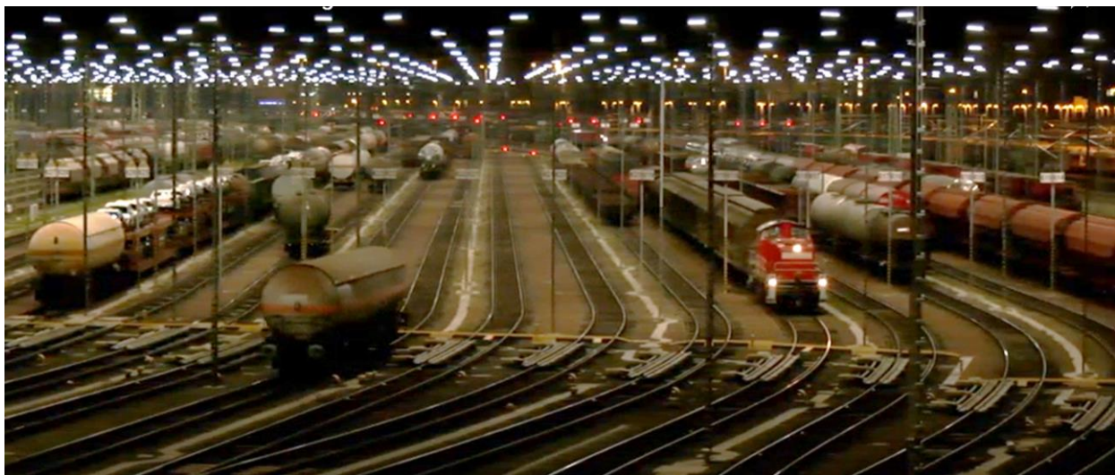
Figura 29: Imagem das condições de iluminação noturna numa triagem da DB Netz (Alemanha)
