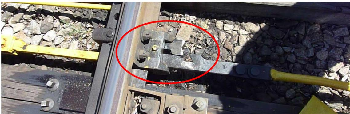
Figura 10: Ferrolho de agrafe existente nos AMV da estação da Livração
