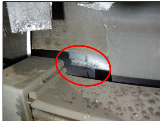
Figur 8: Skrapemerker etter at hjulgang har hatt sideveis bevegelse. Foto: SHT
