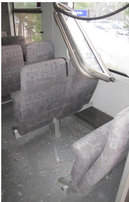
Figur 7: Vindu er slått inn. Foto: SHK
