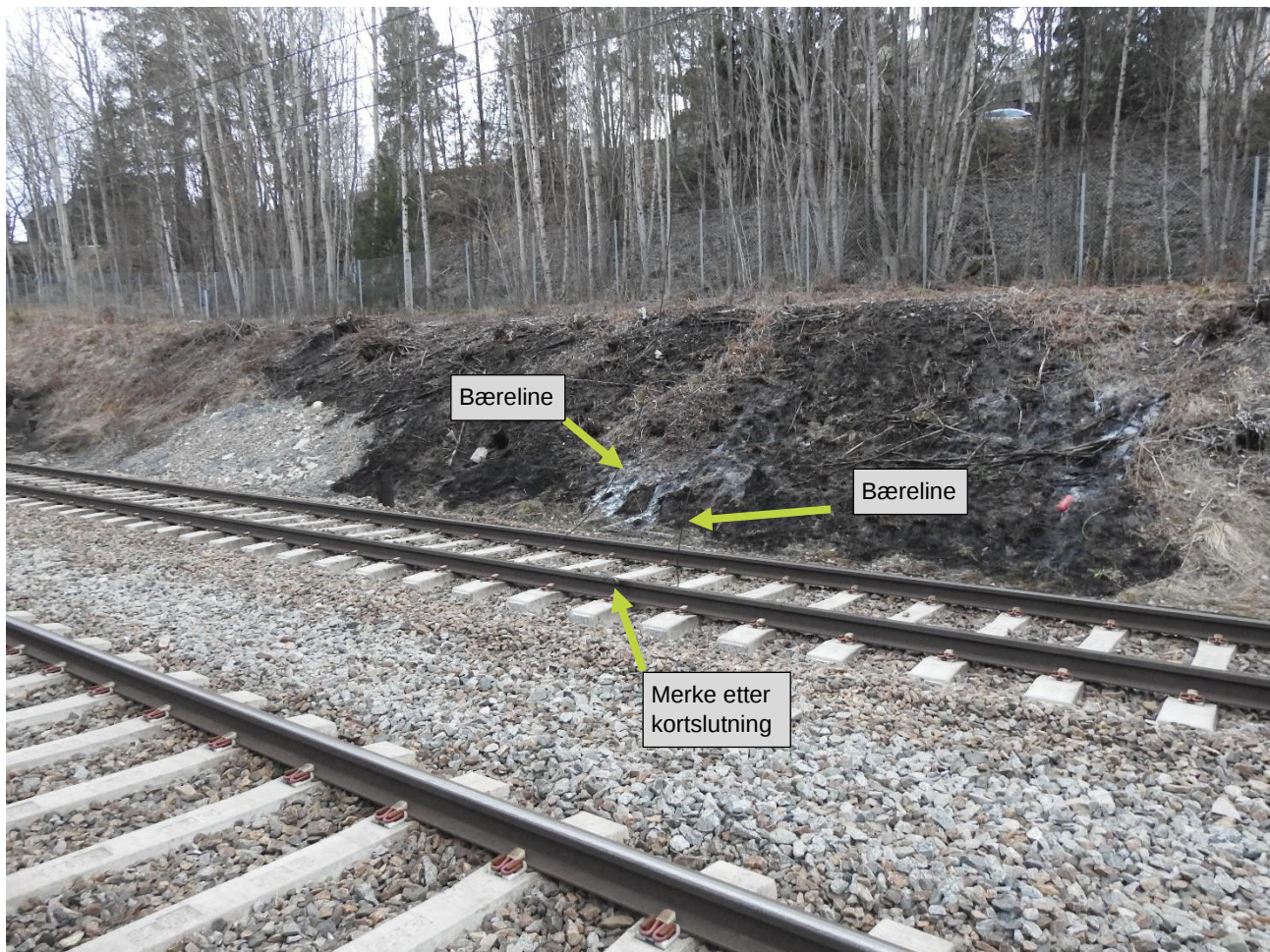
Figur 10: Brannsted ved km 11,923. Foto: SHK
