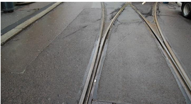
Figur 5: Merker i asfalten etter avsporingen. Foto: SHK
