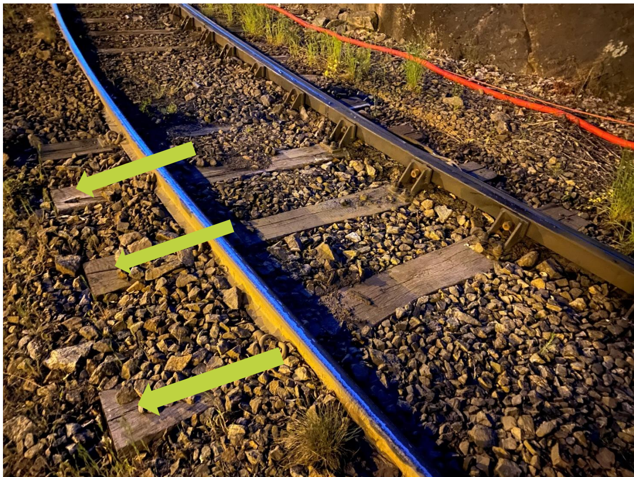
Figur 23: Fra kurven Oslo gate – Kongsveien sett mot Ekebergparken. Sporet har flyttet seg i ballasten. Foto: SHK
