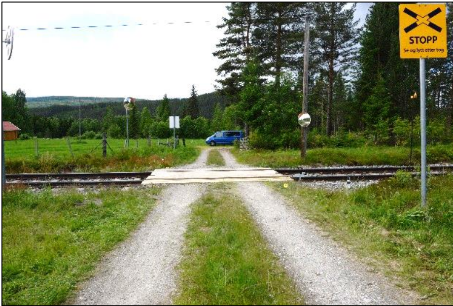
Figur 5: Kroken planovergang. Foto: SHT
