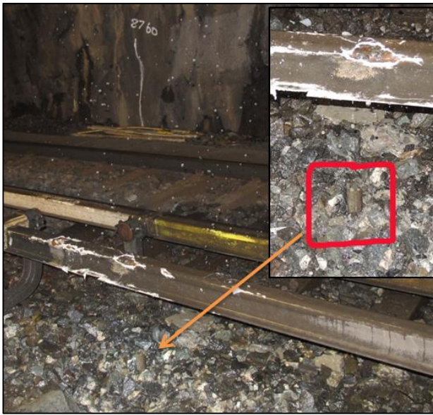
Figur 3: Bit av bor sitter fast ved strømskinne. Foto: SHT
