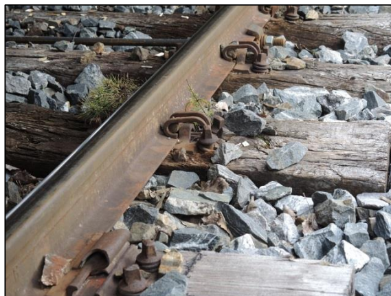
Figur 17: Drennisk befestigelse. Foto: SHT
