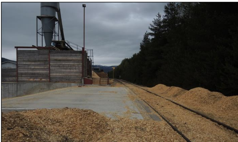
Figur 26: Opplastingsrampe for flis ved Moelven Numedal AS. Foto: SHT
