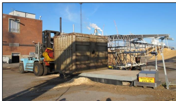
Figur 28: Fliscontainerne veies før de tømmes. Foto: SHT
