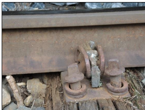
Figur 15: Løse svilleskruer. Foto: SHT
