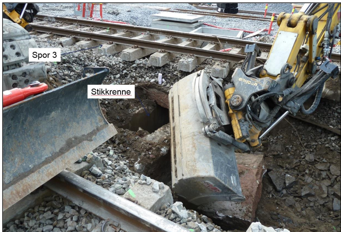
Figur 17: Steinkulvert under spor 3 på Loenga 1. april 2017. Foto og markering: Bane NOR SF
