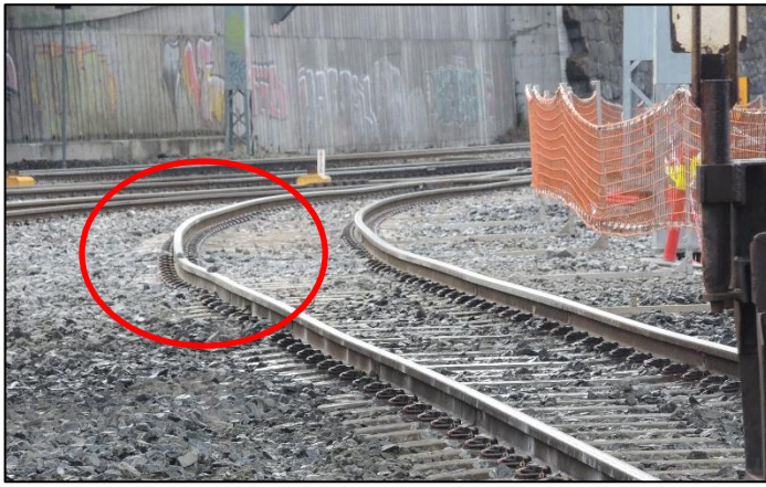
Figur 19: Svank i spor ved avsporsingssted etter avsporing. Foto: SHT
