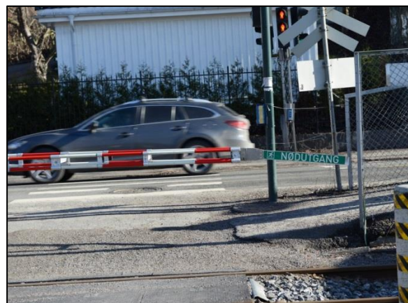
Figur 5: Helbom sett fra innsiden. Foto: SHT
