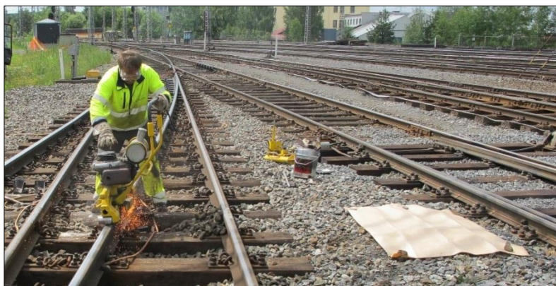
Figur 38: Grovsliping på Alnabru 22.06.2011, kl. 13:18. Illustrasjonsfoto: SHT
