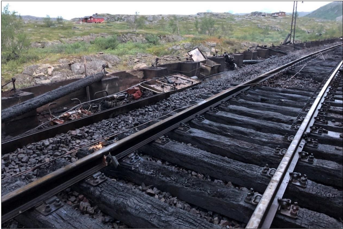
Figur 28: Siste sveis ved ca. km 39,253. Nedbrenning i sviller på hver side av sveiseområdet og utstyr til varme arbeider. Foto: Bane NOR SF
