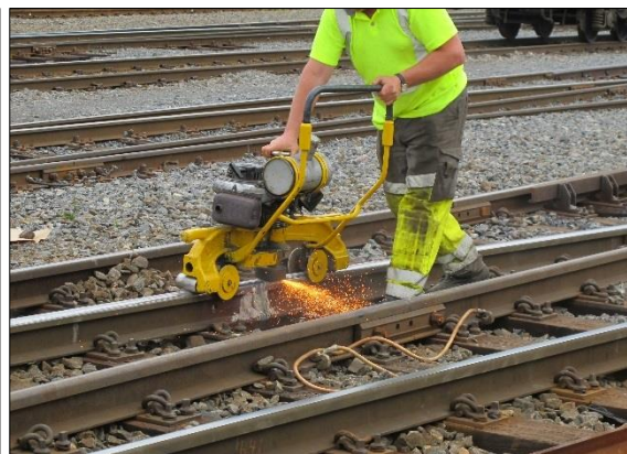
Figur 42: Finsliping på Alnabru 22.6.2011, kl. 13:59. Illustrasjonsfoto: SHT
