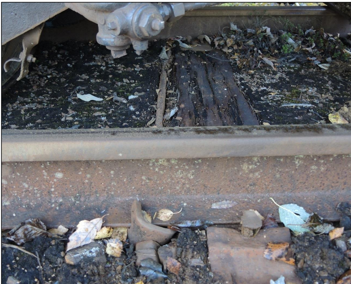
Figur 9: Sporet sikret med strekkbolt. Foto: SHT
