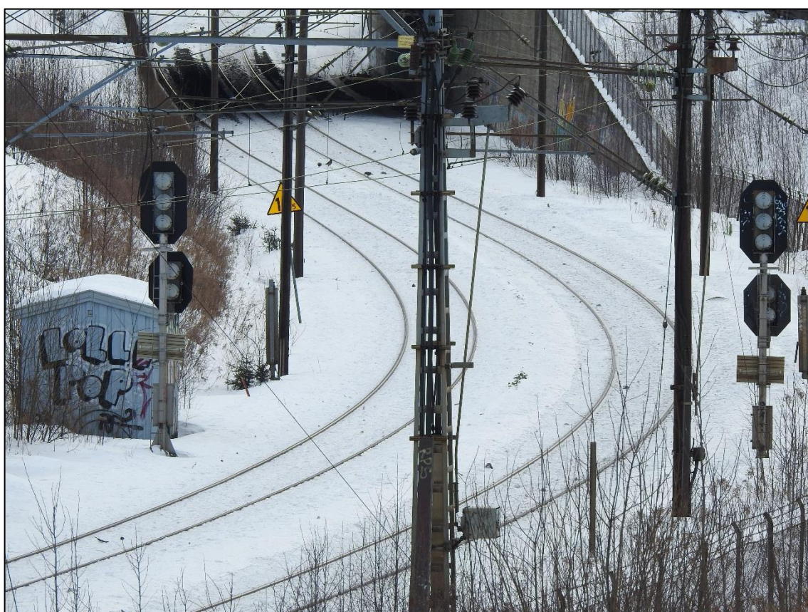
Figur 2: Kulvert retning Oslo S. Foto: SHT
