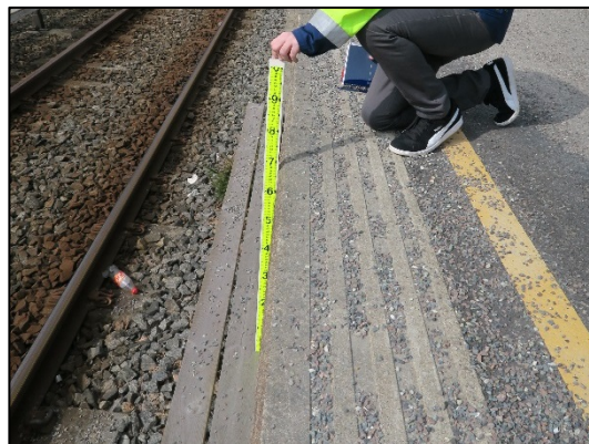
Figur 19: Nedfallssikring på Holstein T-banestasjon. Foto: SHT
