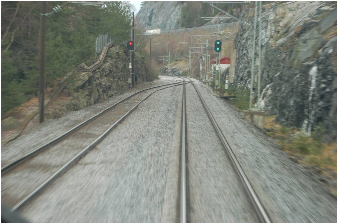
Figur 3: Molykkja stasjon sett fra sør mot nord.
