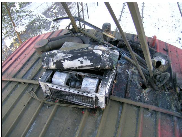
Figur 1: Bilde av avrevet strømvtager i det brannskadde tog 101
