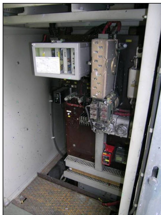
Figur 8: Utstyr med vern i likeretterstasjonen på Slemdal.
