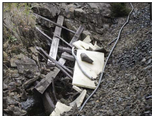
Figur 15: viser hull ved siden av sporet.
