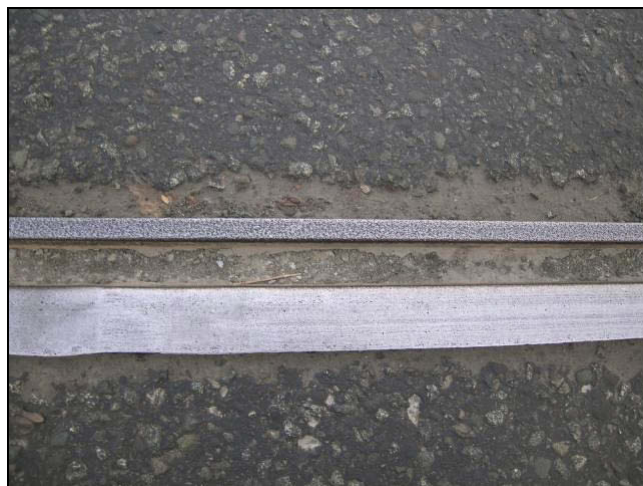
Figur 6: Høyre skinne, blank og uten sort belegg.
