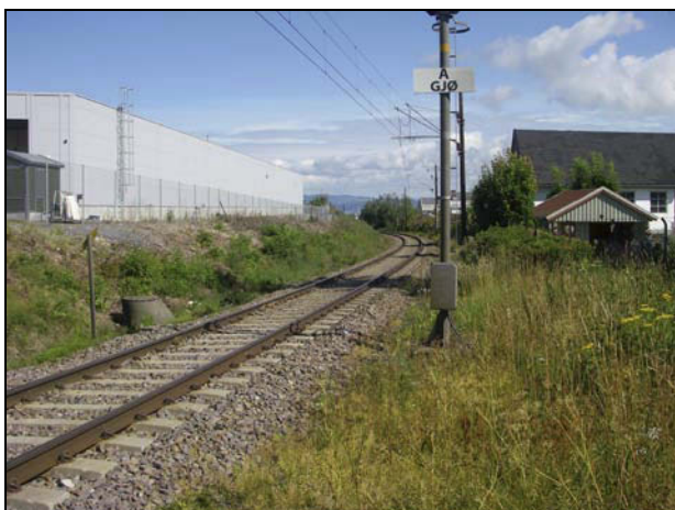
Figur 4: Sikt fra nedsiden av planovergangen, mot Gjøvik.
