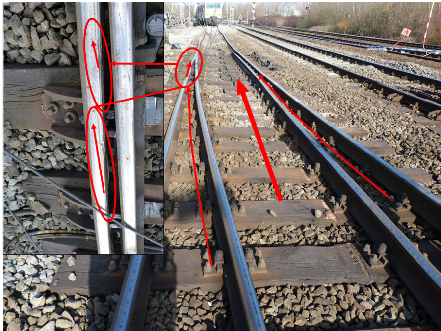
Foto 2: het eerste draaistel dwarst het aanslagspoor.
