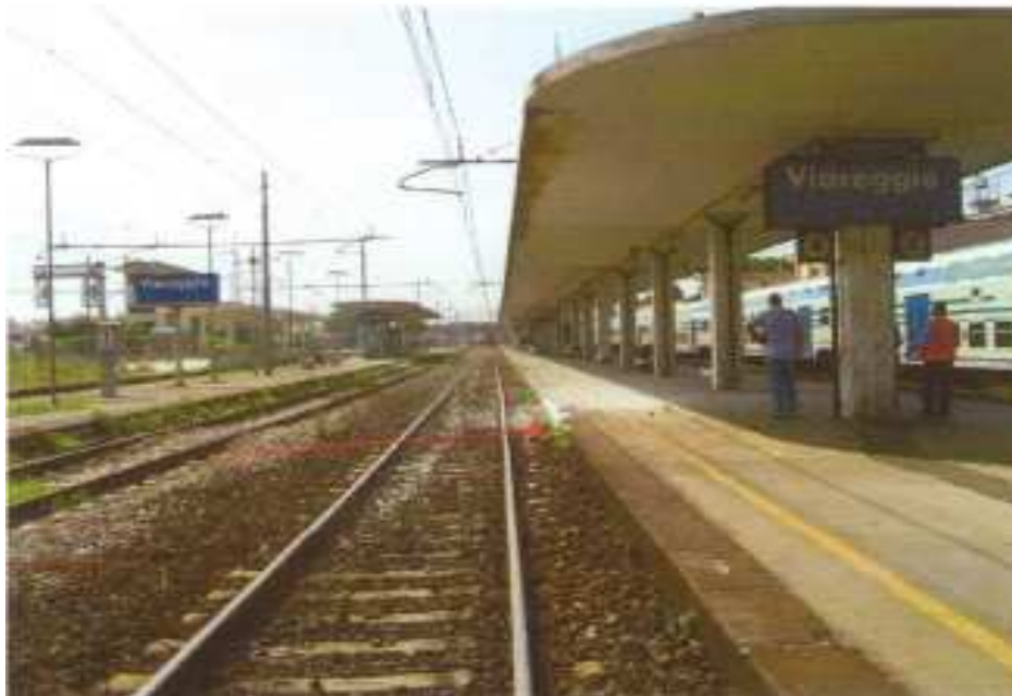
Punto dello svio e conseguente urto sul marciapiede (vista nord – sud) – Fonte Commissione Ministeriale di Indagine
