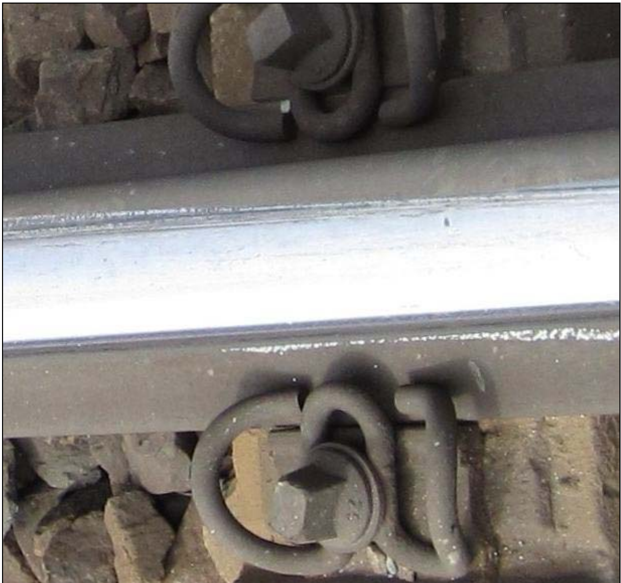
Abb. 15: Entgleisungsspuren
