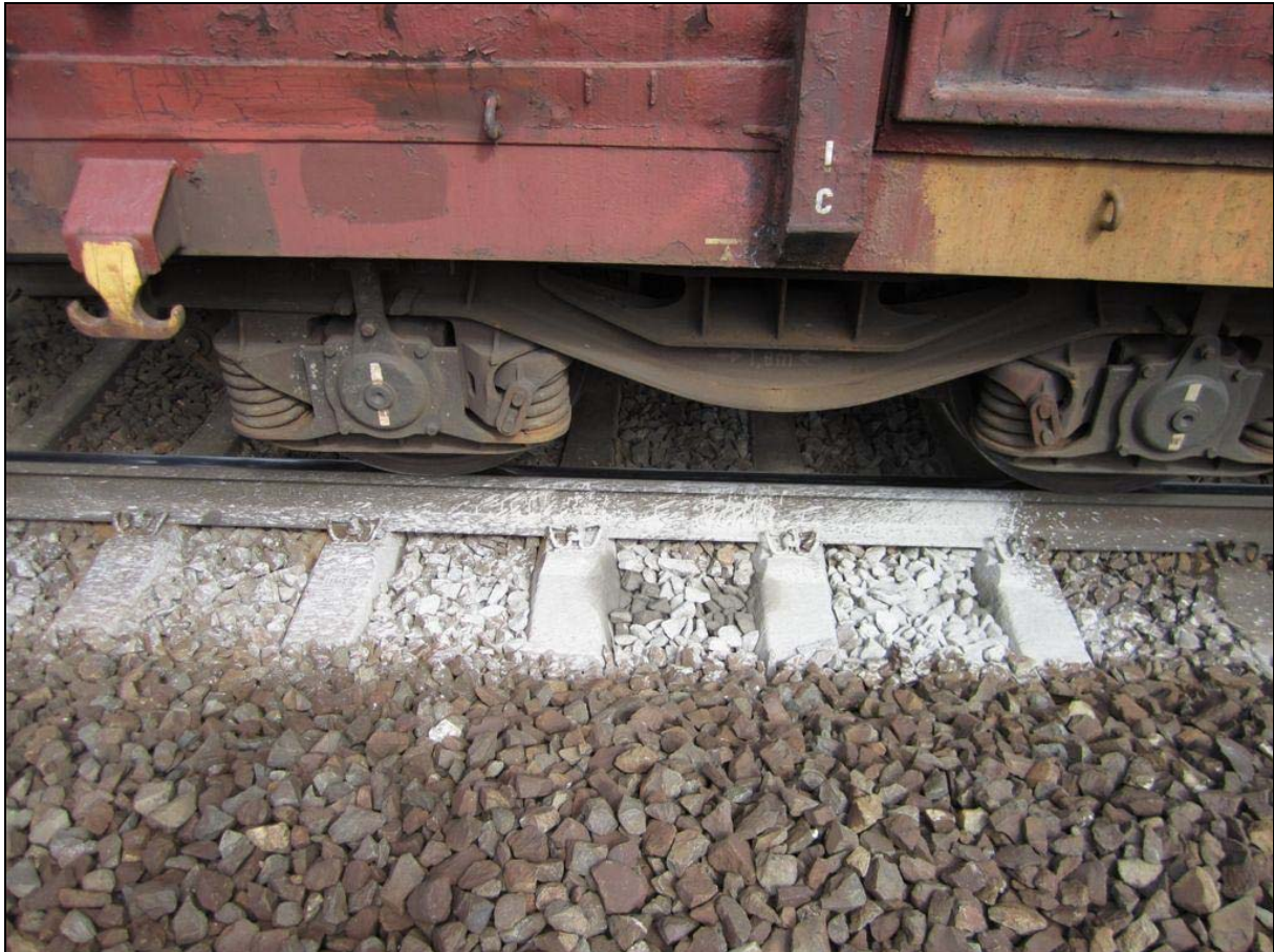
Abb. 14: Schlammstelle in km 21,265
