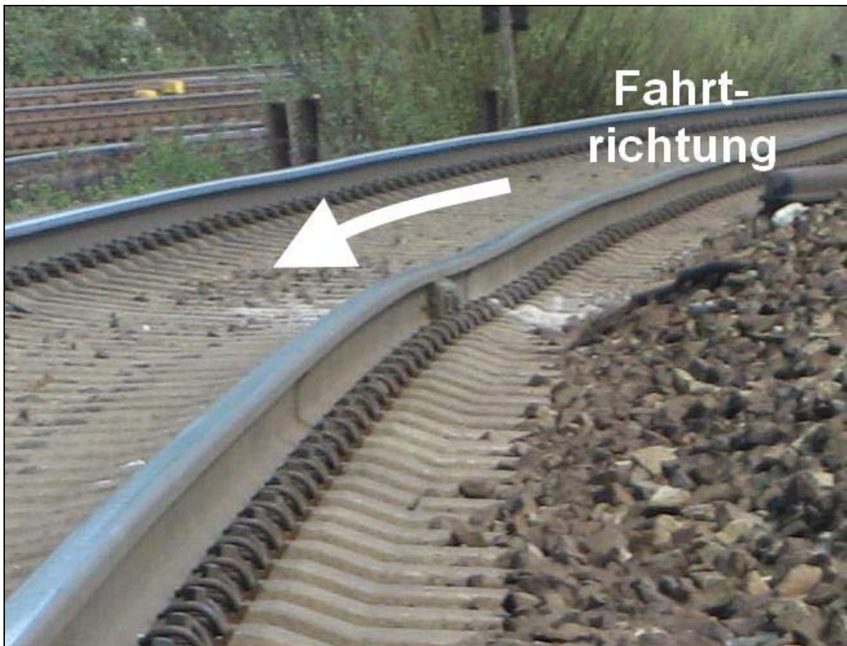
Abb. 6: Stark ausgeprägter Gleislagefehler auf der in Fahrtrichtung linken Schiene
