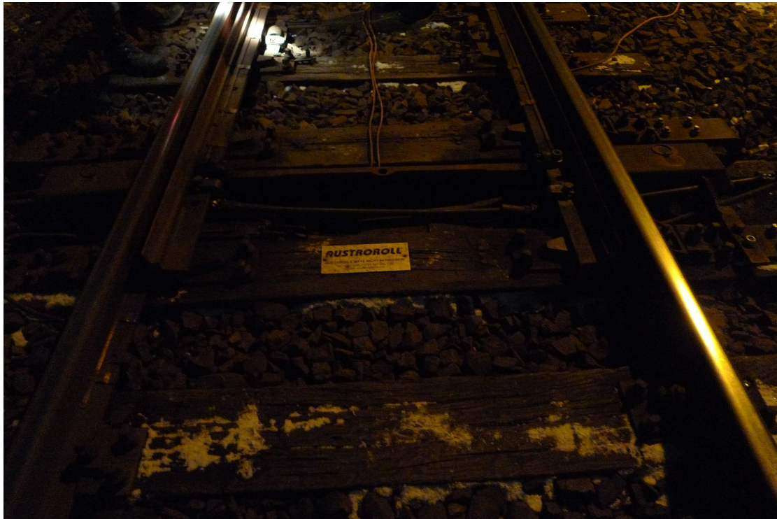
Bild 3: aufgefahrene Weiche 1, Üst Hordorf
