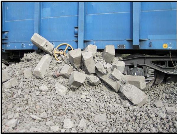
Abb.: 4 zerstörter Oberbau
