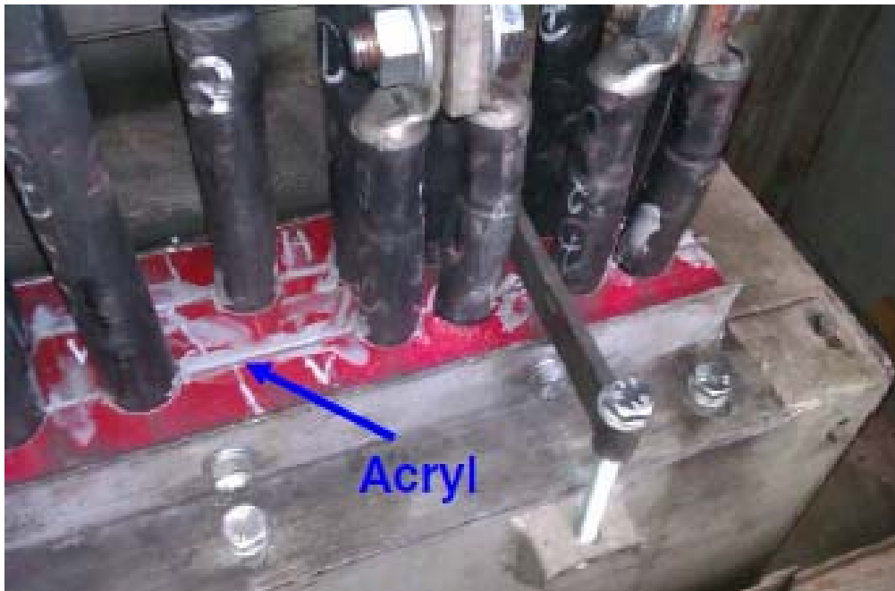
Abb. 18 ordnungsgemäß ausgeführte Fahrmotorklemmstelle
