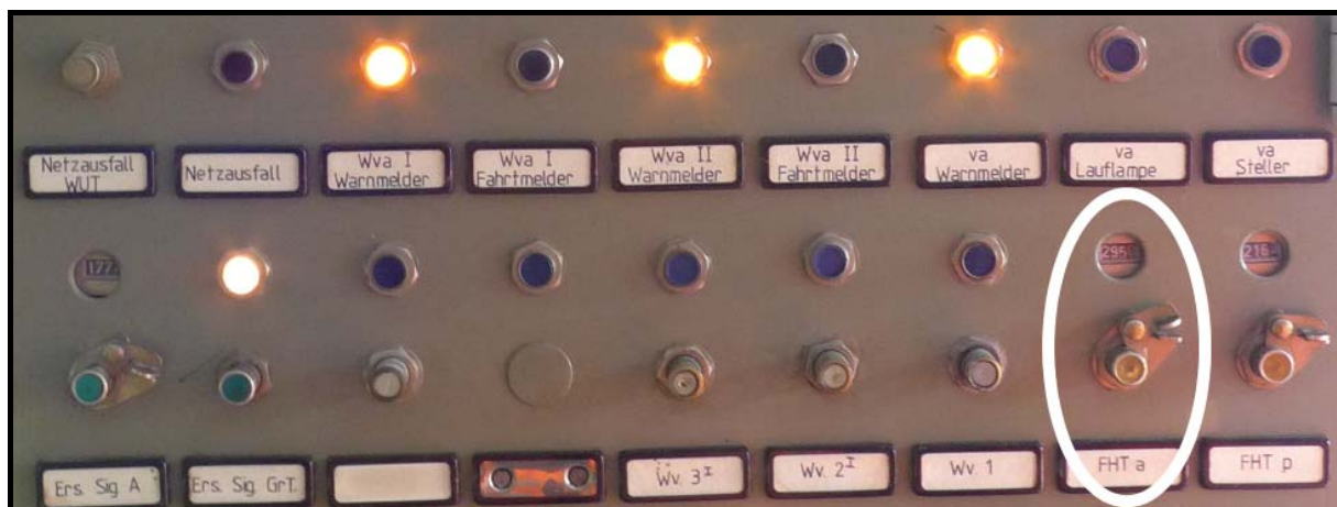
Abb. 4: Hilfsauflösevorrichtung – FHT a
