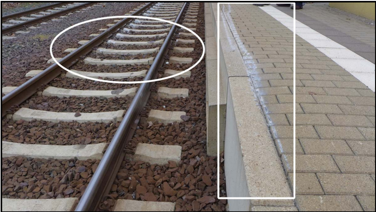
Abb. 8: Entgleisungs- und Schleifspuren
