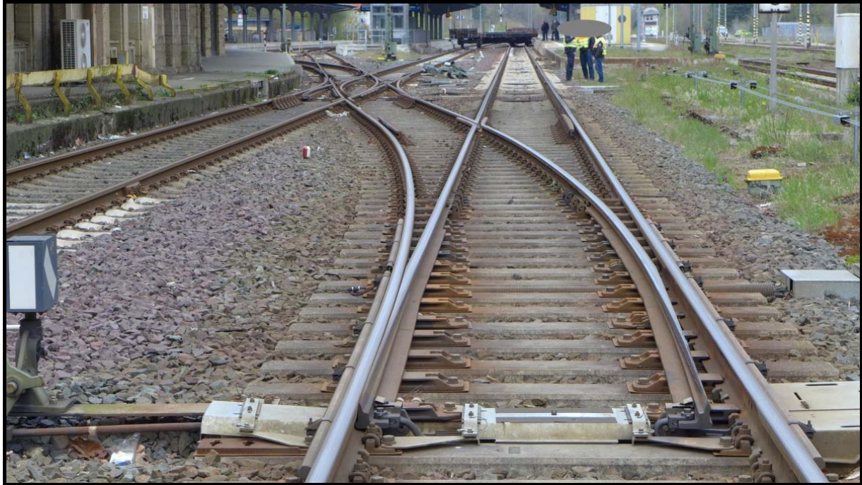
Abb. 10: Weiche 9 (nach Unfall zur Funktionsprobe bereits umgestellt)
