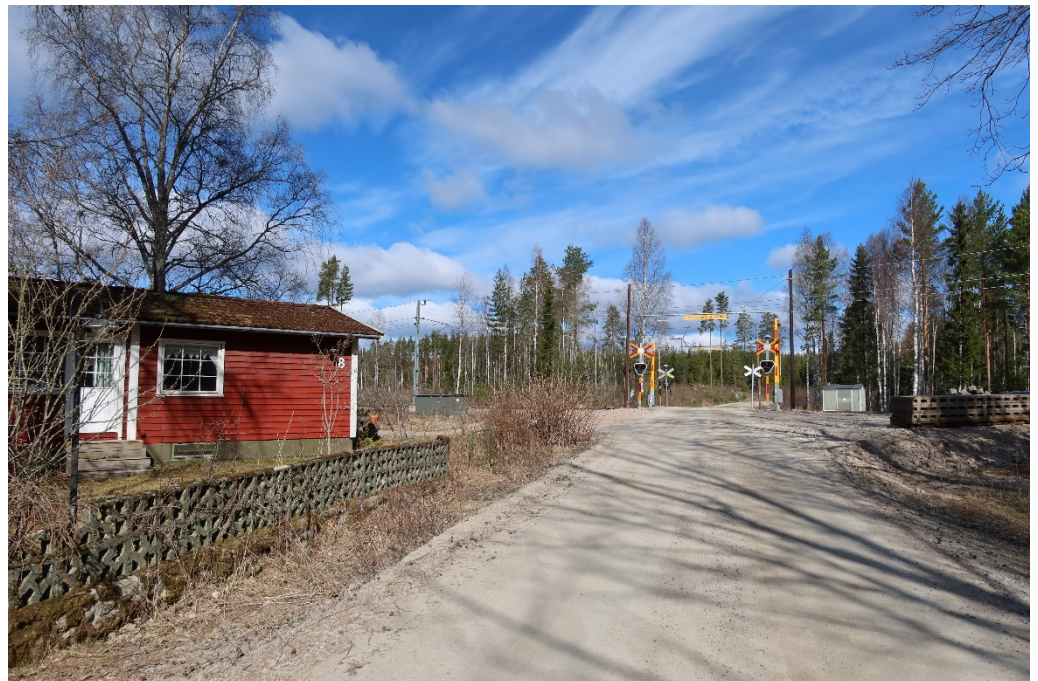
Figur 4. Fäbodäcksvägen som korsar järnvägsspåret i en plankorsning utrustad med halvbommar. Bilden är tagen i samband med ett platsbesök den 24 april 2020.
