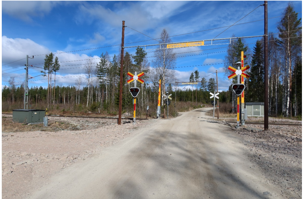
Figur 16. Plankorsningen har bommar som spärrar trafiken in över järnvägen på höger sida i respektive riktning, en s.k. halvbomsanläggning. Bilden är tagen i samband med ett platsbesök den 24 april 2020.
