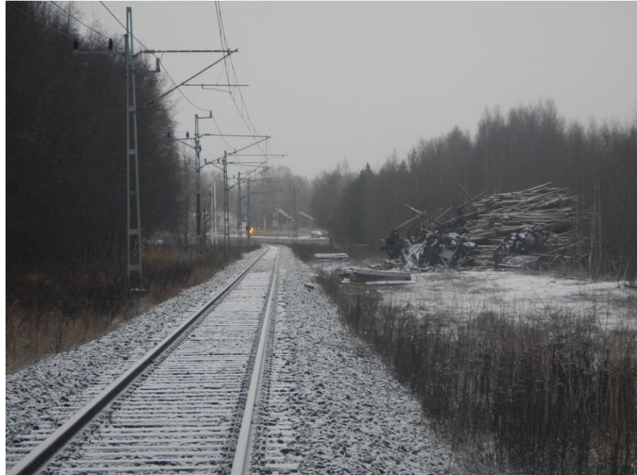
Figur 5. Olycksplatsen. Fotot taget några veckor efter olyckan.
