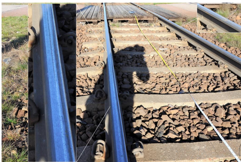
Figur 12. Delförstoringar som visar märken efter en fläns på vänster räl samt en motsvarande diagonal förflyttning på höger räl närmast gångvägen.
