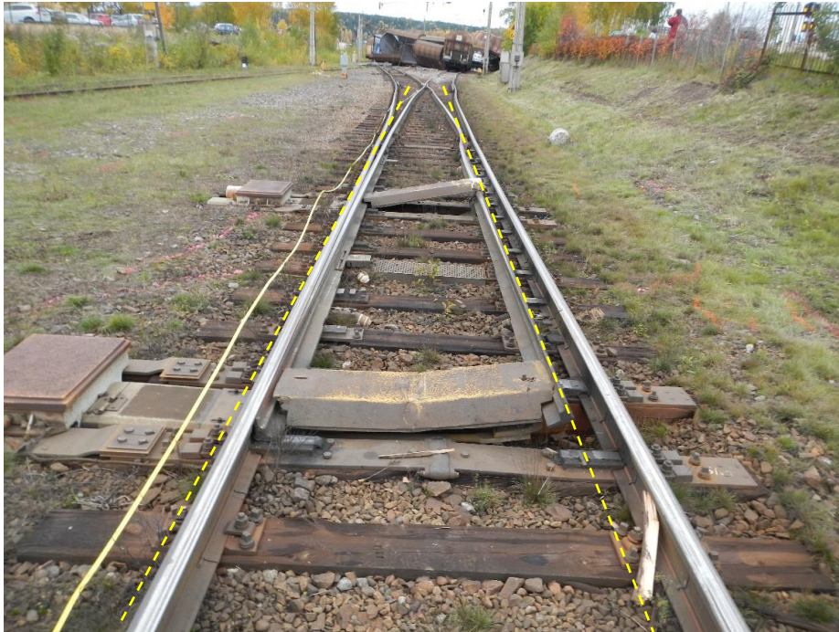
Figur 49. Den urspårade hjulaxelns bedömda väg genom växel 468 markerad med streckade gula linjer.
