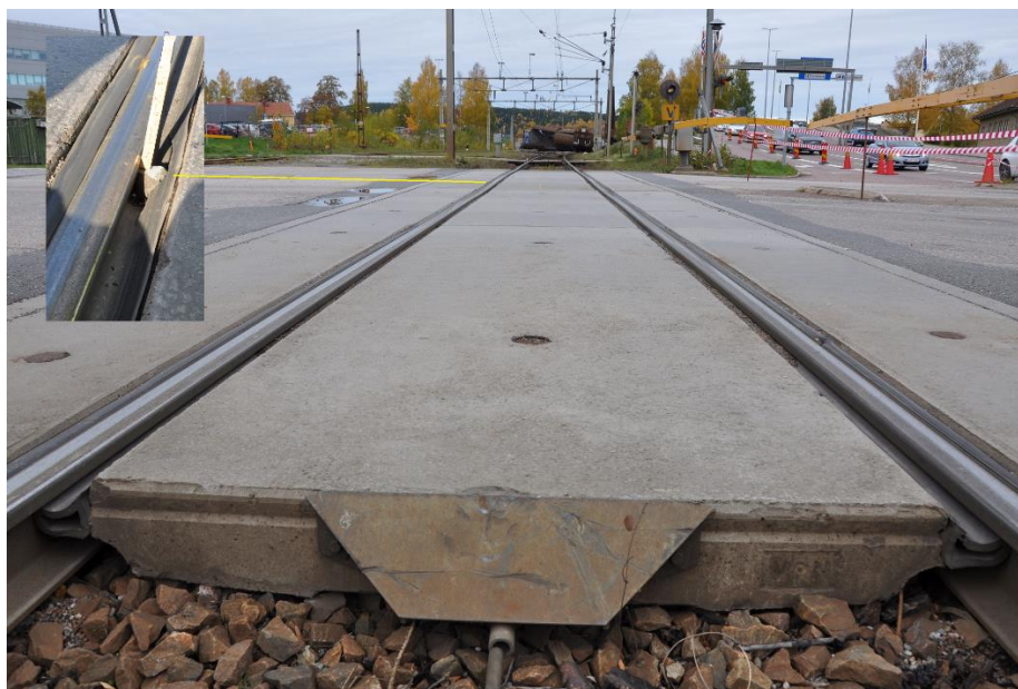
Figur 11. Bild mot olycksplatsen över Lyviksvägens plankorsning. Den infällda bilden visar makadamstenen i den vänstra flänsrännan.
