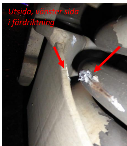
Figur 28. Skador på fjädring.
