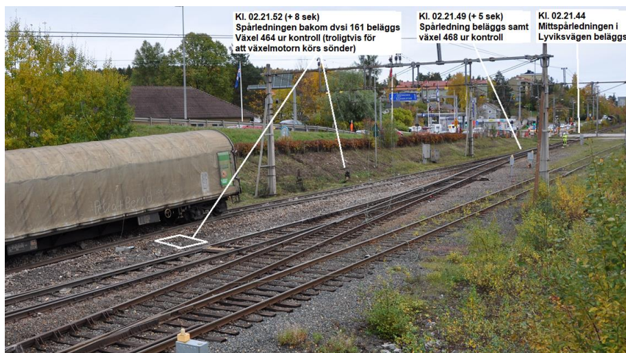
Figur 9. Bild bakåt i tågets färdriktning mot växel 468 och Lyviksvägen som illustrerar indikeringarna i manöversystemet.
