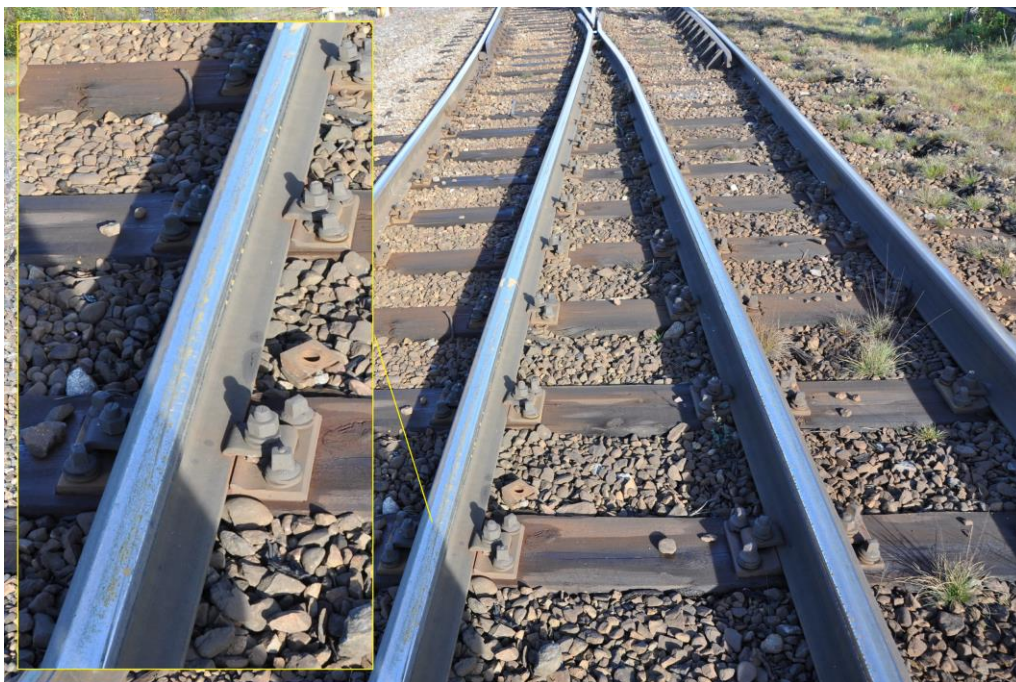
Figur 17. Delförstoring som visar diagonalt märke över vänster räl.
