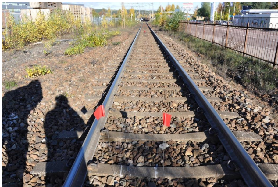
Figur 10. Bild mot olycksplatsen med islagsmärken synliga på den närmaste slipern.
