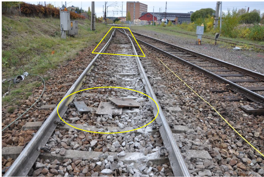
Figur 23. Bild bakåt mot växel 468 med den inringade balisgruppen för orientering om hastighetsnedsättning till 60 km/tim samt det troliga området där Rd2- och V5-loken separerades från varandra (den gula linjen mellan spåren är ett måttband).
