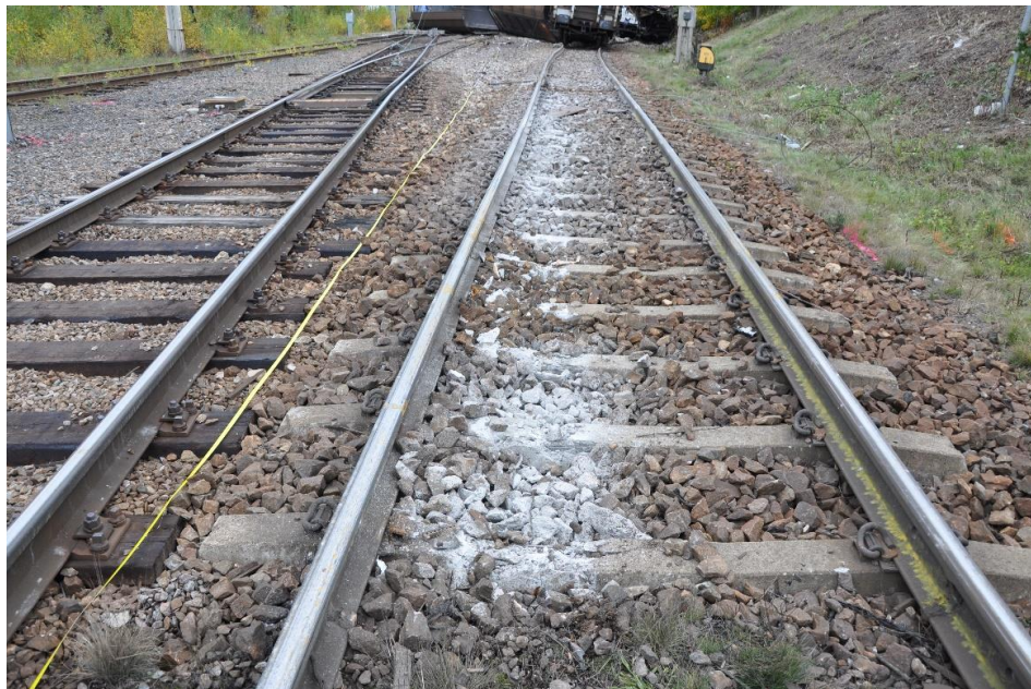
Figur 19. Bild på skador i spåret vidare mot de urspårade vagnarna.
