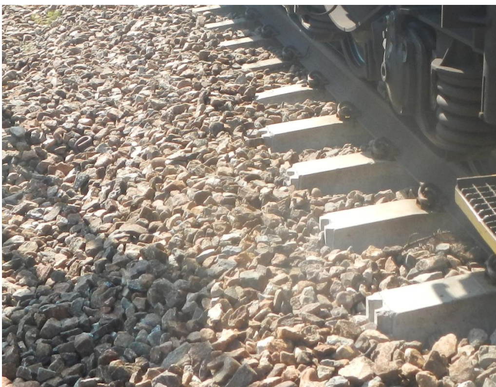
Figur 3. Nedsårets utsida på platsen där sidoförskjutning skett.
