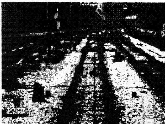
Foto 4: il segnale basso 32 in normale efficienza fotografato ad una distanza di circa 5 metri dalla cabina di un locomotore E 632 dello stesso tipo di quello coinvolto nell'incidente durante il sopralluogo del 16.07.2008 (sullo sfondo, oltre i deviatori 16 e 14, l'area dell'impatto indicata dalla freccia rossa)
