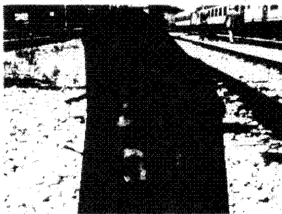
Foto 3: il segnale basso 32 fotografato durante il sopralluogo del 16.07.2008 con un'unica luce accesa al fine di simulare la condizione presente all'atto dell'incidente
