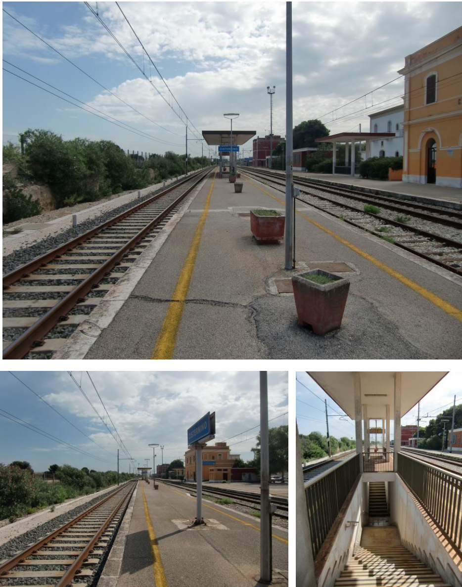
Figura 10 . Foto della pensilina che inibisce la visibilità del PL km 710+403, in uscita dalla stazione di Cisternino, nella direttrice di marcia del treno ES AV 9351 (verso Brindisi)
