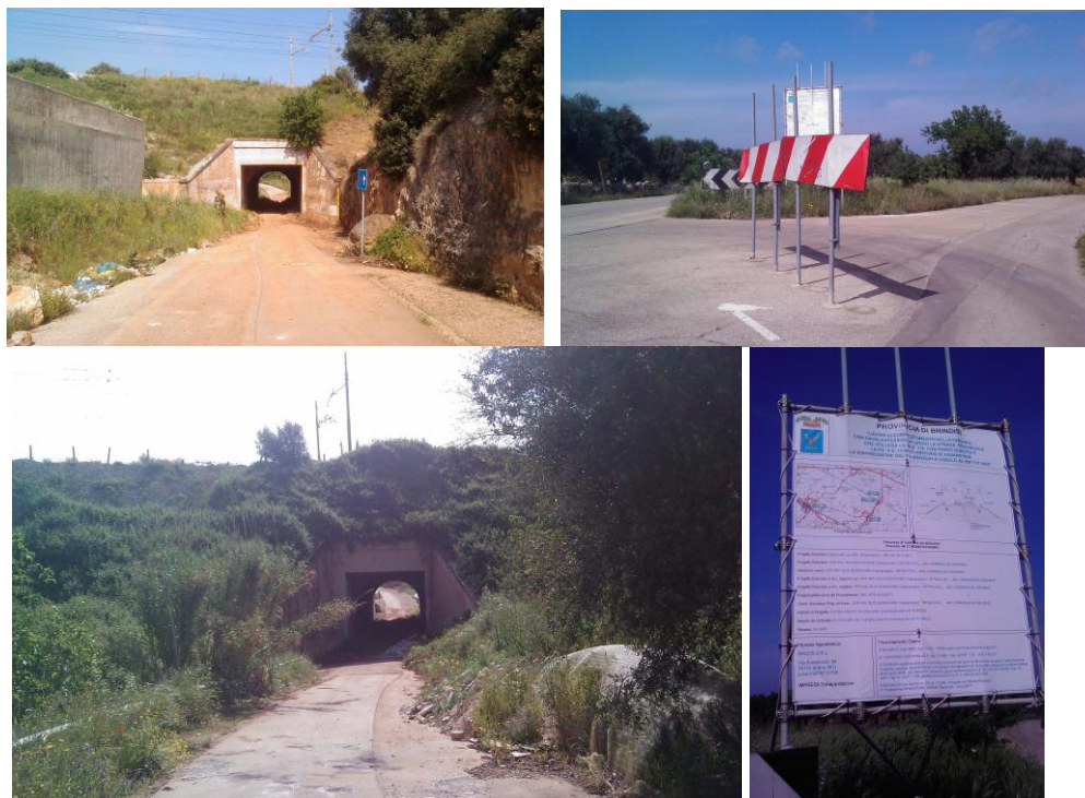
Figura 17 . Foto relative alla viabilità alternativa al P.L. km 710+403 che sarebbe dovuta essere realizzata per eliminare il PL
