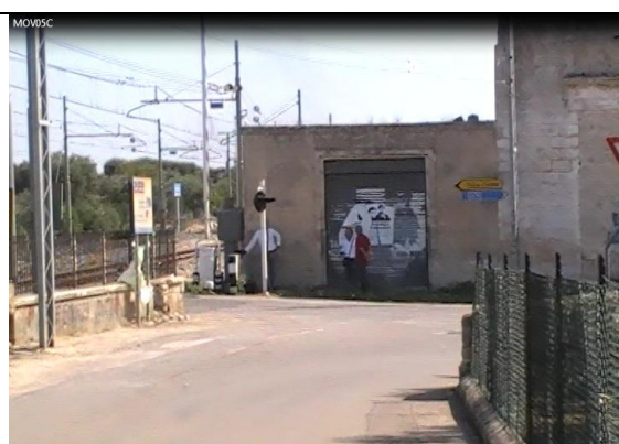
Figura 15: Incrocio stradale a ridosso del PL km 710+403, lato monte, visto da Strada Provinciale 7
